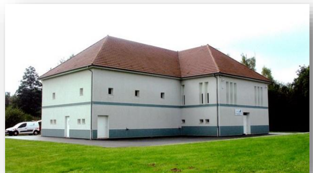
Station après les travaux en 2010
