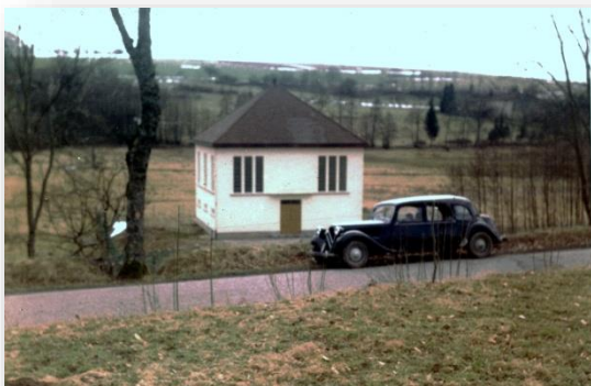
Station de pompage et traitement d'Uzemain en 1961
